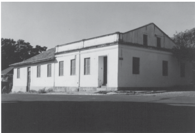
Figura 1 - Fachada da Casa Gomes Jardim antes das obras do restauro arquitetônico.
